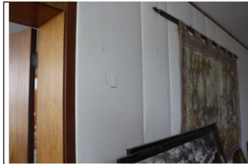
Salão Nobre com tecido dos painéis perfurados e rasgados
